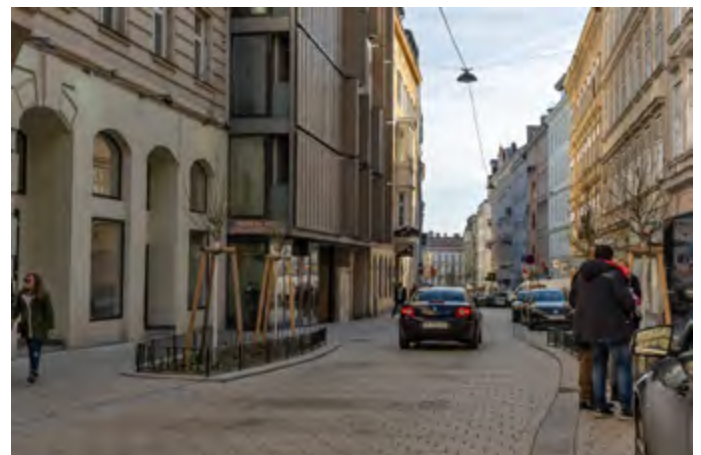
Podoba Otto-Bauer-Gasse po její přestavbě na zónu sdíleného prostoru (Begegnugszone) – jedna úroveň, prvky zklidnění dopravy, nová zeleň, optimalizace počtu a polohy parkovacích míst [46].
