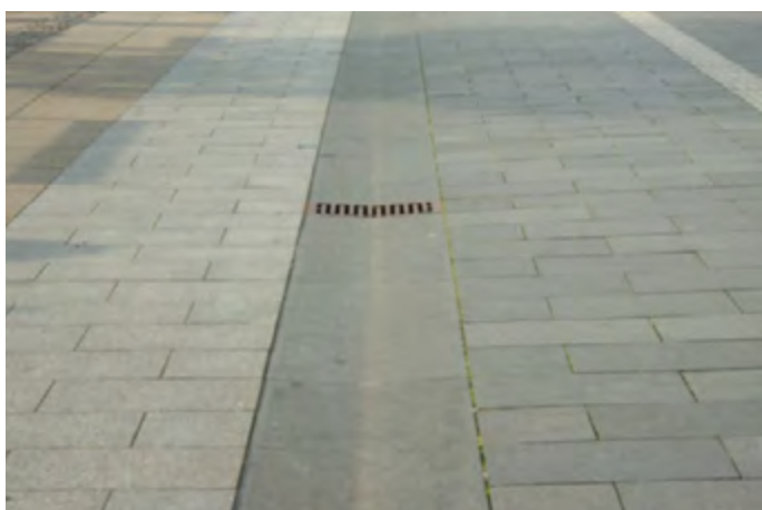
Příklad podélného žlabu vytvořeného ze žulových dílců na okraji prostoru určeného pro pohyb motorových vozidel (foto: Rambøll).
