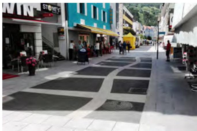
Použití několika vzorů, barev a typů povrchu člení plochu a zároveň vymezuje koridor pro jízdu vozidel a cyklistů, jejichž dlouhá linie je záměrně narušena „vlnovkou“ i střídáním povrchů [41].
